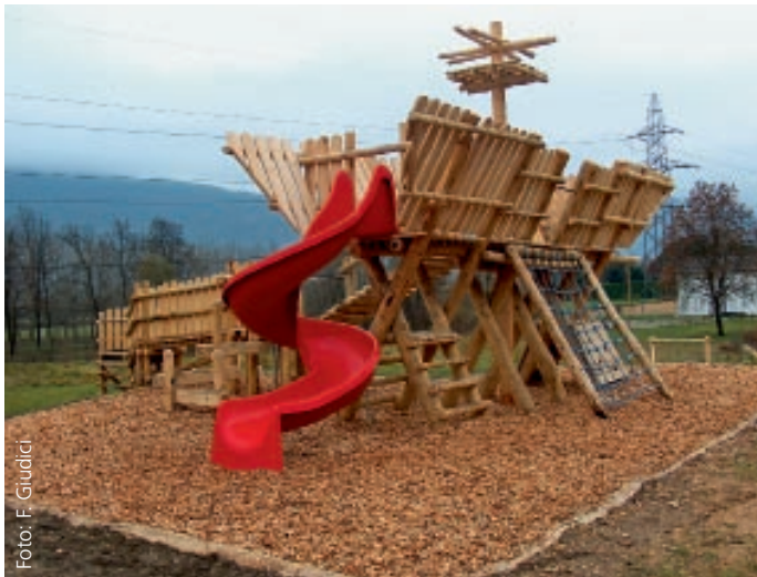
Der 40 cm dicke Bodenbelag unter der «Arche Noah» in Gudo ist aus Kastanienholzschnitzeln und erfüllt alle Sicherheitsaspekte.
